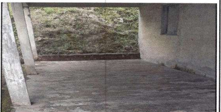
FOTO 12: Sustitución de piso de Cemento por piso de Granito.
