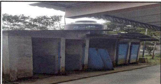
FOTO 11: Mantenimiento a puertas de Servicios Sanitarios.
